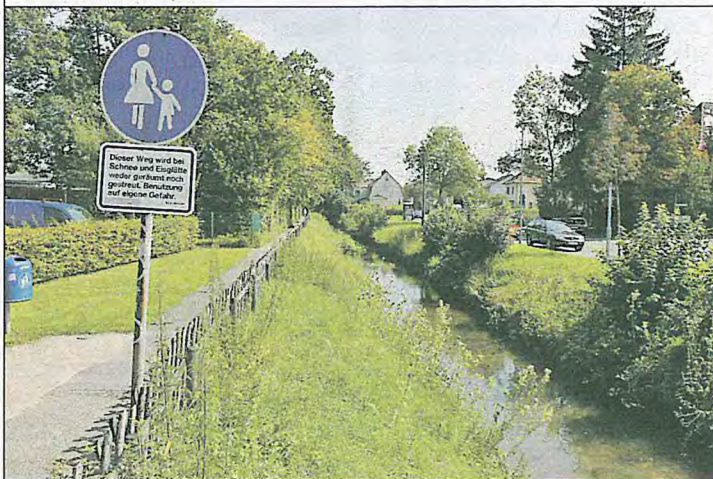
Bis kurz hinter die Brücke im Bereich der Dr.-Martin-Luther-King-Straße reicht der Zuständigkeitsbereich des AHW. Die Sanierung des weiteren Verlaufs des Baches wird später vom Land umgesetzt. Fotos: sd
