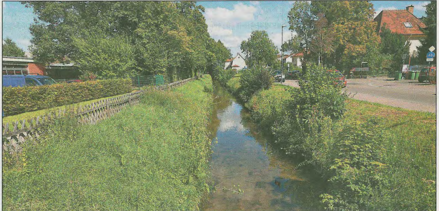
Bestandteil des Gesamtpaketes „Hochwasserschutz“ ist der Ausbau des Leimbachs in Wiesloch, zwischen der ehemaligen Alten Post und der Luther-Straße. Der Bach soll fit für ein Jahrhunderthochwasser werden, zudem wird der Weg entlang des Bachs ausgebaut. Foto: Pfeifer
