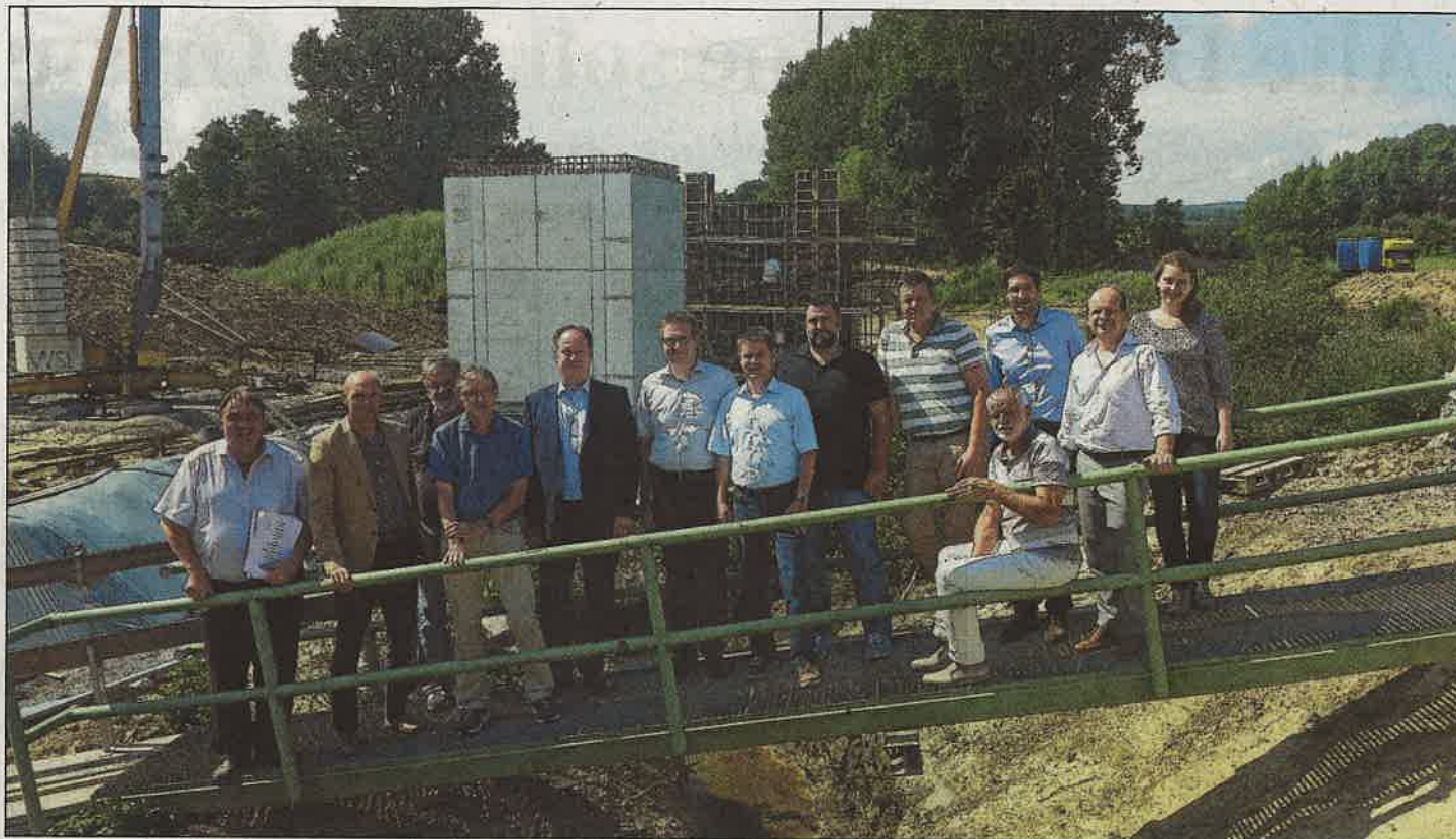
Die Mitglieder der Verbandsversammlung des AHW waren mit der Geschäftsleitung unterwegs zu den Baustellen des Verbands; hier sind sie am Standort des im Bau befindlichen Hochwasserrückhaltebeckens Schatthausen. Foto: AHW
