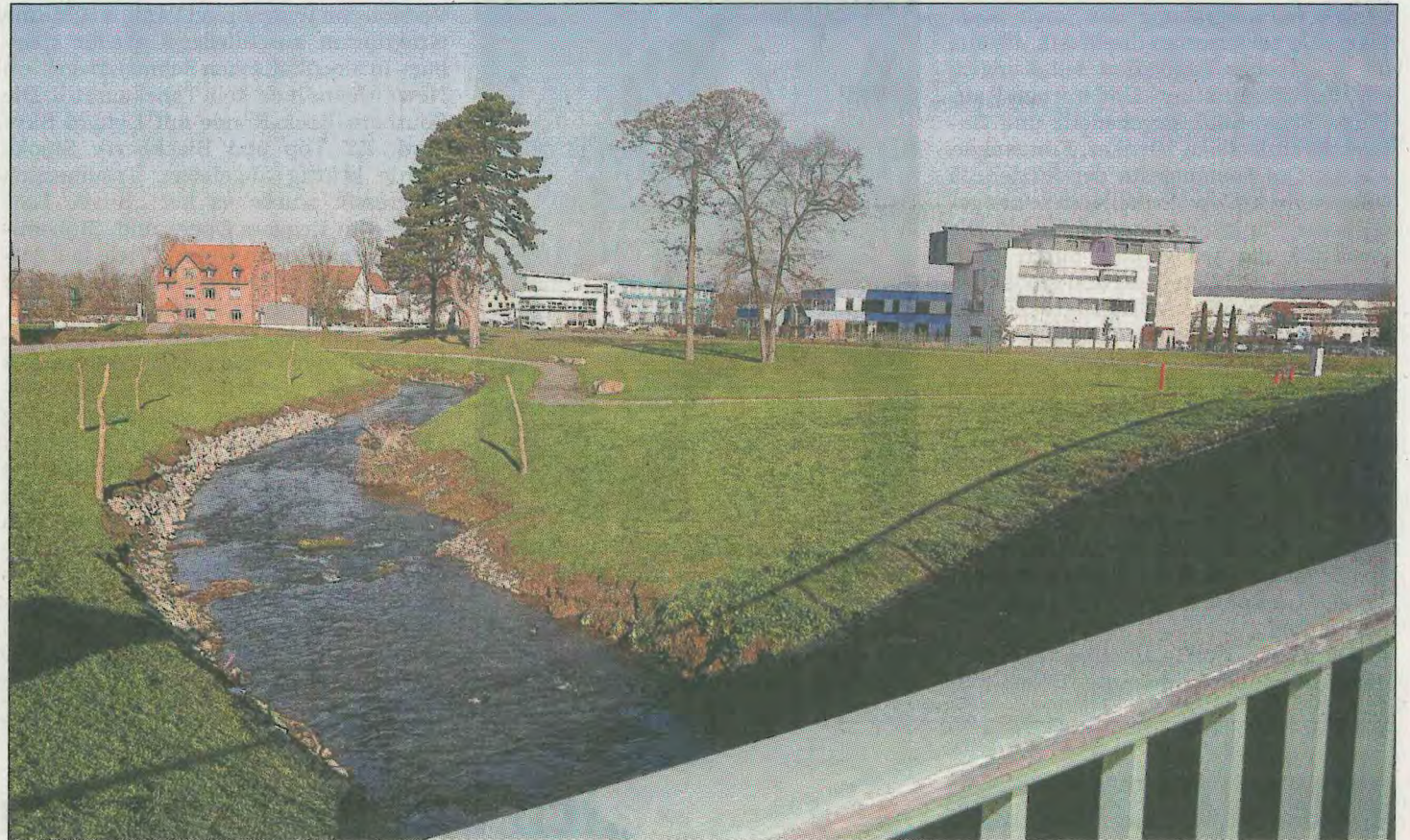
Der neue Leimbachpark im Gewerbegebiet Weinäcker „schafft ein tolles Umfeld für Gewerbebetriebe“, so OB Dirk Elkemann. Alle Flächen im Gewerbegebiet seien inzwischen verkauft, freut sich das Stadtoberhaupt. Foto: Pfeifer
