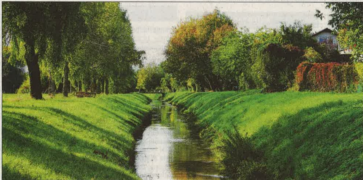
Seitlich versetzt von der Walldorfer Straße fließt der Leimbach. Auch dieser Bereich muss „hochwassersicher“ gemacht werden. Foto: Siegfried
