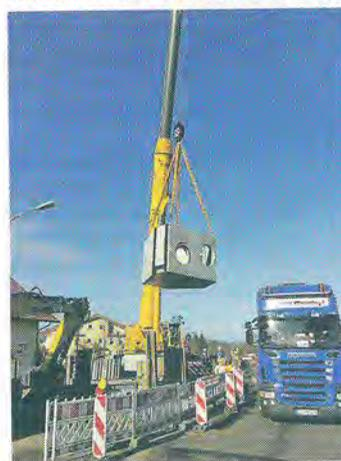
Im August 2014 haben wir mit der Baumaßnahme begonnen. Die Arbeiten der Verlegung des zusätzlichen Verbandskanales kommen gemäß Bauzeitenplan gut voran. Derzeit befinden wir uns oberhalb des Kreisels, Ortseingang von Malschenberg. Durch das Einbringen des sogenannten Vereinigungsschachtes (siehe Bild) wurde ein weiterer Bauabschnitt realisiert. Dieser Schacht ist notwendig, um die ankommenden und fortlaufenden Kanäle hydraulisch zu vereinigen, damit eine gleichmäßige Ableitung des
