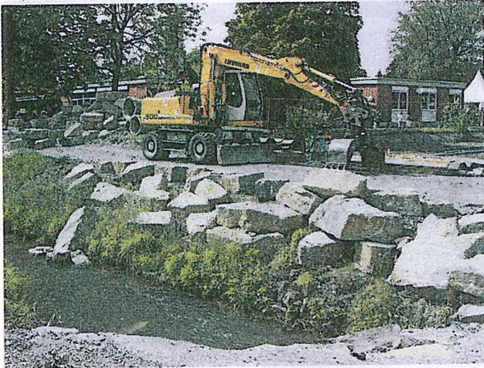
Mit schwerem Gerät werden die Gesteinsbrocken verlegt.
