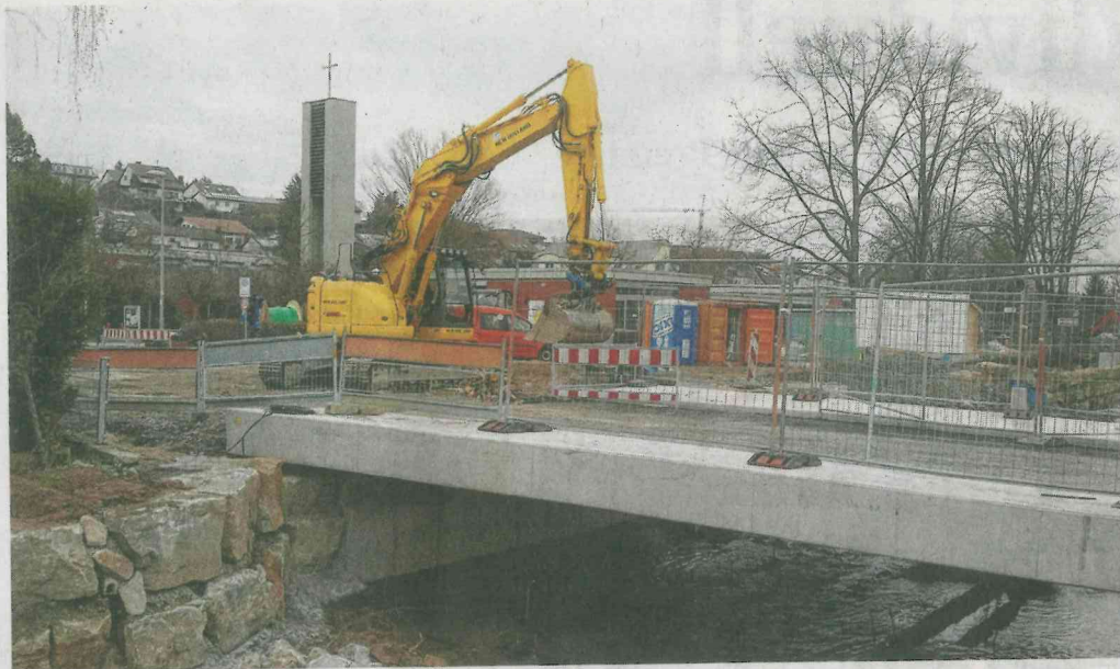
Zum 1. März sollen die größten Arbeiten an der Brücke erledigt sein.
