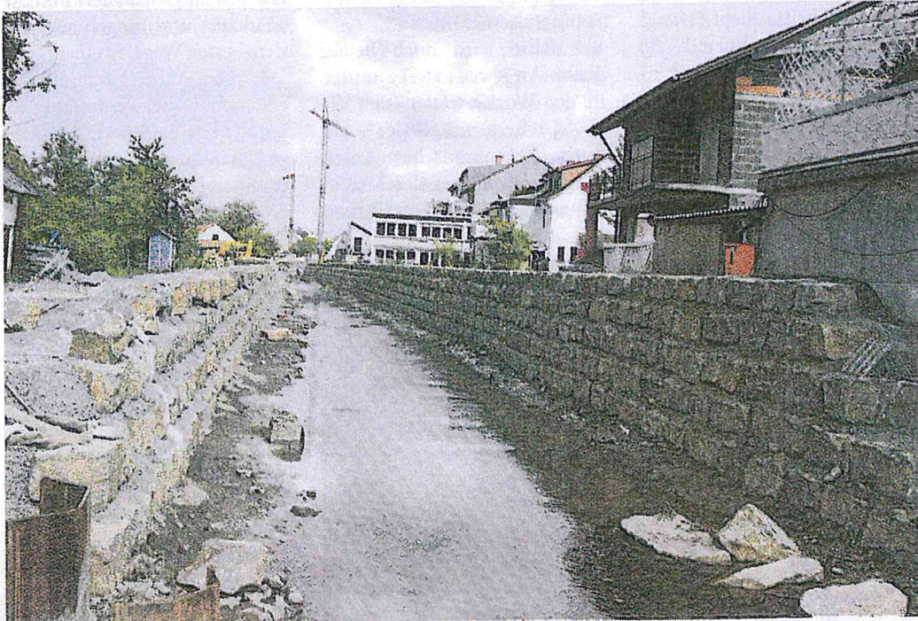
Die Sanierungsarbeiten liegen derzeit völlig im Zeitplan.
