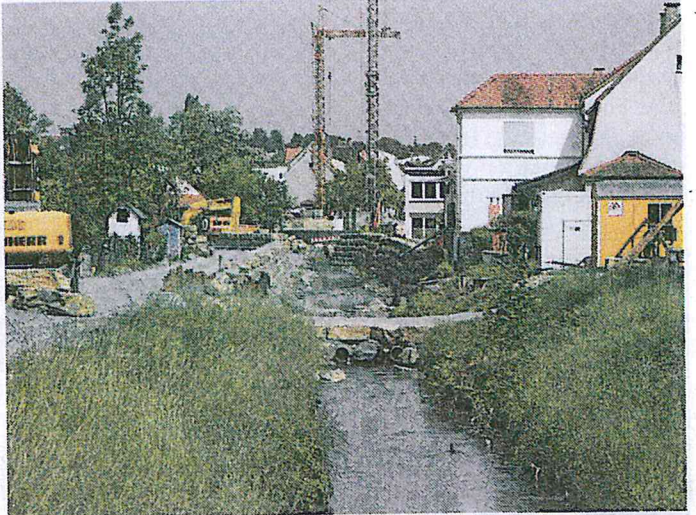
Die derzeit laufenden Arbeiten sind Bestandteil eines Gesamtpaketes zum Hochwasserschutz. Fotos: khp
