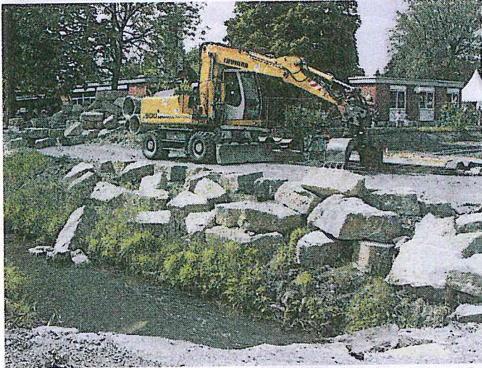
Mit schwerem Gerät werden die Gesteinsbrocken verlegt.
