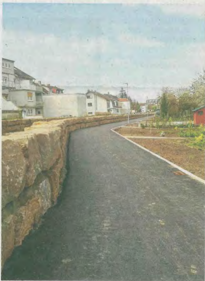
Der neue Fuß- und Radweg mit modernster Beleuchtung ist bereits fertig gestellt.
