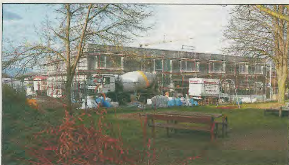
Zügig voran geht es mit dem Kinderhaus in Rettigheim, in das die Gemeinde rund 2,7 Millionen Euro investiert. Mitte 2016 soll es in Betrieb gehen.
