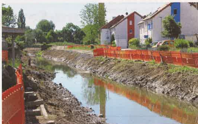
In Richtung Freibad sollen die Arbeiten bis Sommer 2020 abgeschlossen sein. Im Hintergrund sieht man das Wellpappen-Gelände und die Pegelmessbrücke der Landesanstalt für Umwelt.
