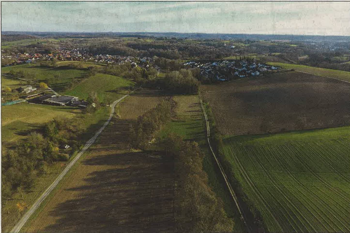
Blick auf den künftigen Standort des Hochwasserrückhaltebeckens Ochsenbachtal, das rechts von der Straße zwischen Schatthausen (im Hintergrund zu sehen) und Ochsenbach für 1,8 Millionen Euro gebaut wird. Für den 70-prozentigen Zuschuss des Landes wurde jetzt der Förderbescheid übergeben. Foto: AHW
