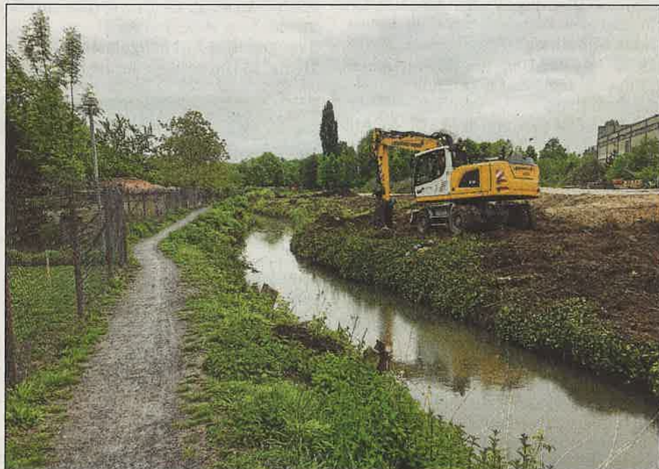
Im unteren Bereich des Waldangelbachs (in Höhe von Freibad und ehemaliger Wellpappe) haben die Arbeiten zum Hochwasserschutz begonnen. Foto: Stadt Wiesloch
