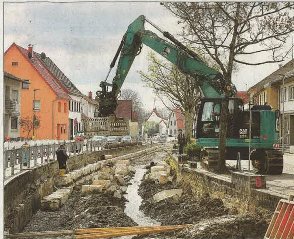
**Baiertal.** Vermutlich bis März des kommenden Jahres sollen die Arbeiten am Gauangelbach abgeschlossen sein. Derzeit werden dort im Rahmen des Hochwasserschutzes das Bachbett und die Uferbefestigung gegen mögliche Hochwasser ausgebaut. Von den insgesamt 500 Metern, die am Gauangelbach bearbeitet werden, sind nach Aussage vom technischen Geschäftsführer des Abwasser- und Hochwasserschutzverbands Wiesloch, Josef Zöllner, etwas mehr als die Hälfte geschafft.
