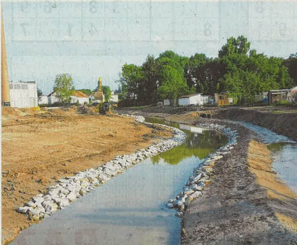
Baumaßnahmen: In den vergangenen Tagen wurde das neue Bachbett des Waldangelbaches fertig gestellt und geflutet. Auf der rechten Seite ist noch das bisherige Bachbett erkennbar, das bereits stillgelegt wurde.
