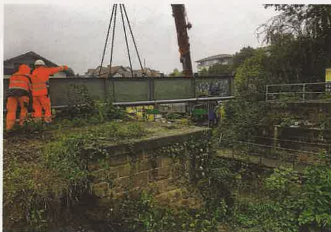
Die sechs Tonnen schwere Stahlbrücke wurde mit einem Autokran an ihrem bisherigen Standort am Waldangelbach auf Höhe der ehemaligen Wellpappe abgebaut.
