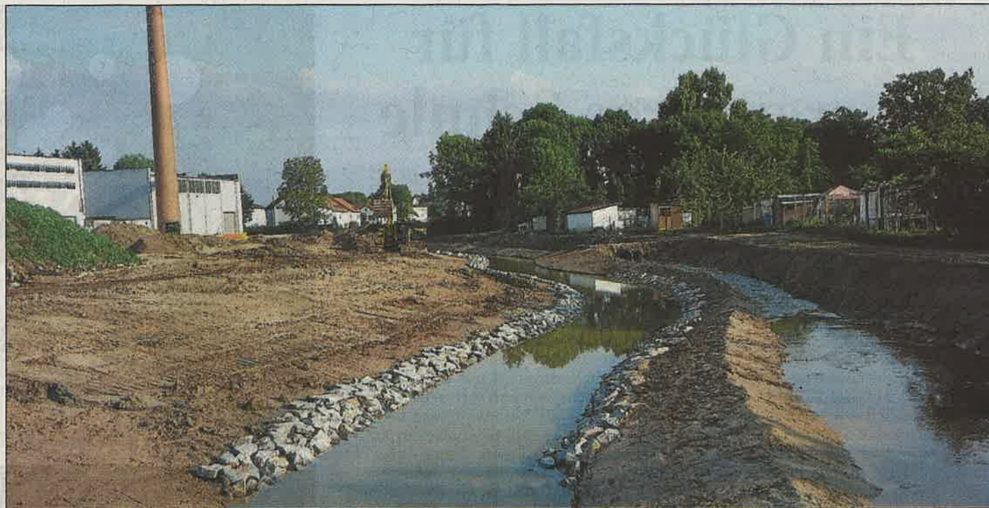
In den vergangenen Tagen wurde das neue Bachbett des Waldangelbaches zwischen der Kleintierzuchtanlage und der ehemaligen Wellpappe fertiggestellt und geflutet. Auf der rechten Seite ist noch das bisherige Bachbett erkennbar, das bereits stillgelegt wurde. Foto: AHW
