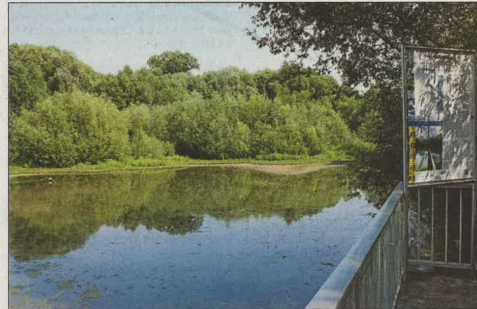
Eine Folge des Hochwassers vom Juli 1969. Ab 1982 wurde das Rückhaltebecken in Mühlhausen gebaut: Startschuss für den Hochwasserschutz in der Region. Foto: Kloeé
