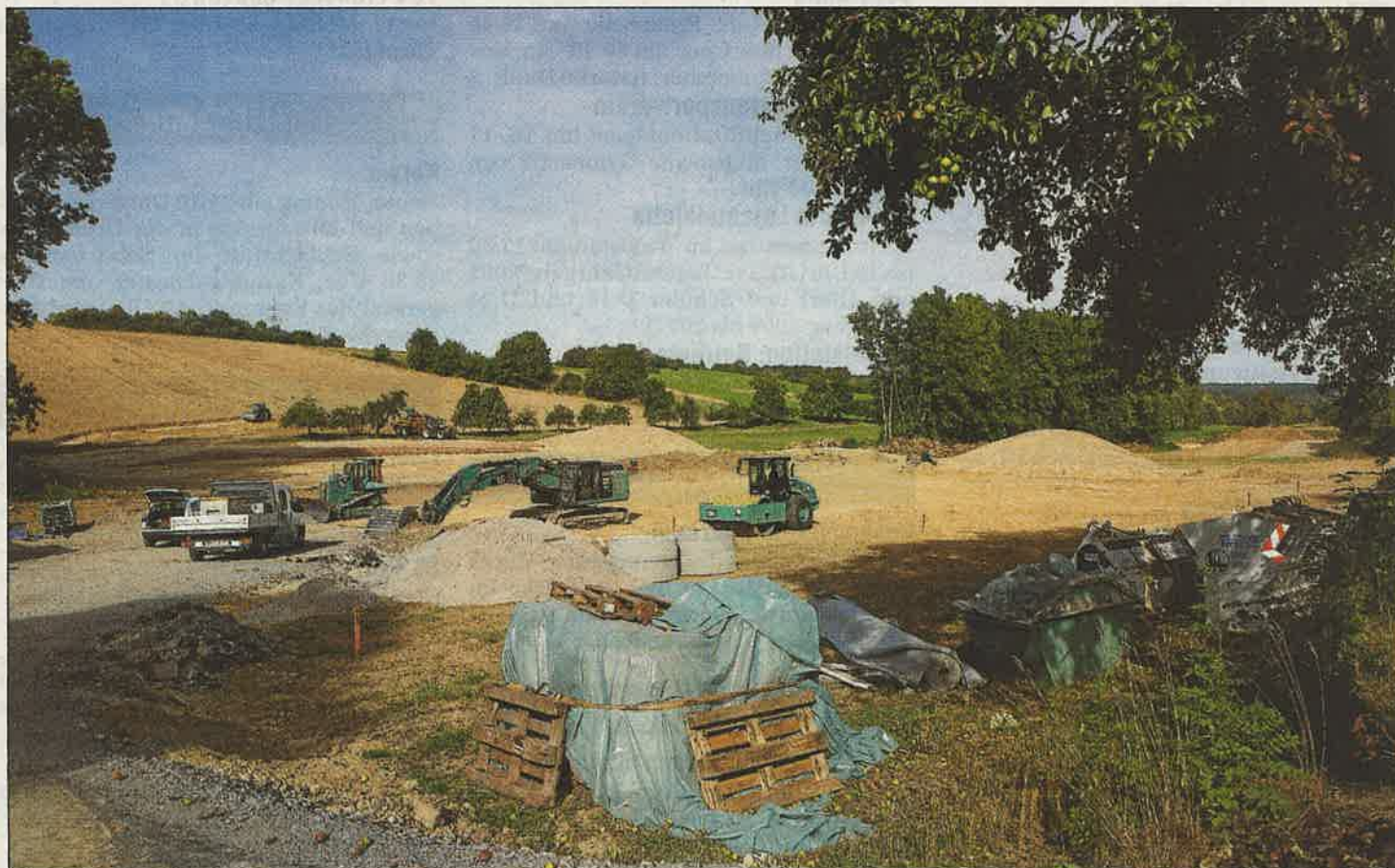
Dem Schutz insbesondere von Schatthausen und Baiertal soll es dienen, aber durch seine naturnahe Gestaltung später auch Tieren und Pflanzen eine Heimstatt bieten: das Hochwasserrückhaltebecken zwischen Schatthausen und Ochsenbach. Foto: Pfeifer
