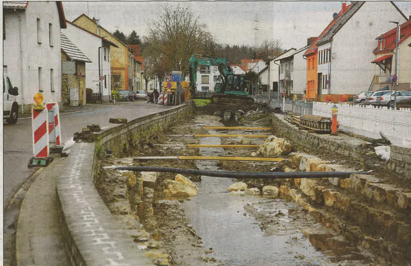
Der Ausbau des Gauangelbachs in Baiertal geht voran. Er ist eine der zahlreichen Schutzmaßnahmen, die im Zusammenhang mit dem Jahrhunderthochwasser ergriffen werden. Foto: Helmut Pfeifer
