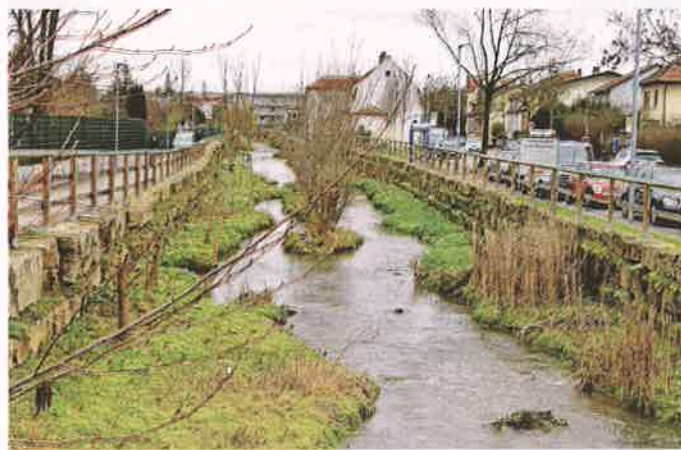
Der Leimbach - hier im Bereich der Schwetzingen Straße in Wiesloch - ist in diesem Bereich hochwassersicher ausgebaut
