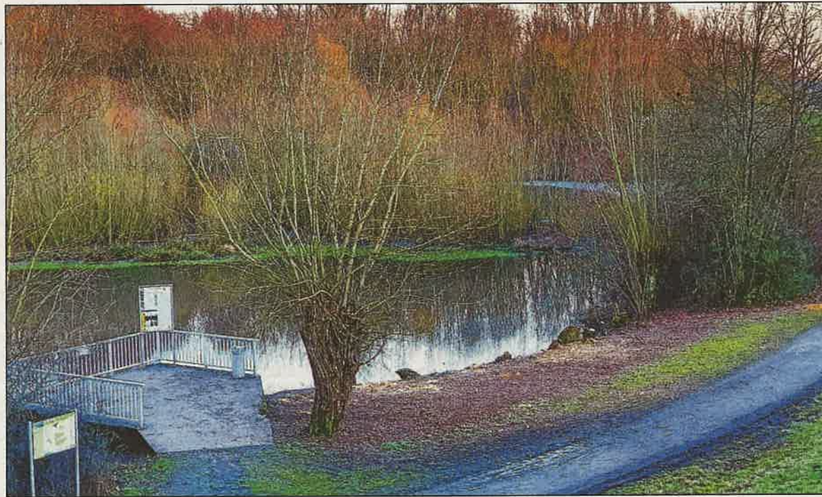
Rechts neben dem Einlaufbauwerk mit der Aussichtsplattform wurden Rodungen am Ufer des Mühlhausener Hochwasserrückhaltebeckens durchgeführt. Unter anderem sollen Fischwanderungen ermöglicht werden. Foto: Pfeifer
