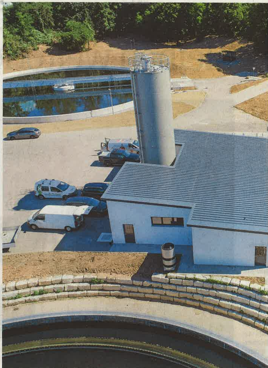
Für die vierte Reinigungsstufe wurden das Multifunktionsgebäude und das Sedimentationsbecken (im
