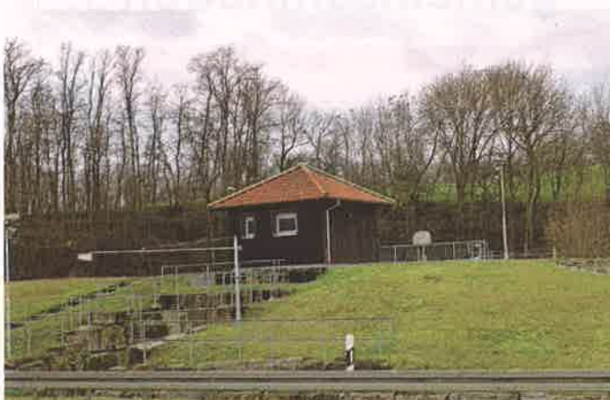
Regenrückhaltebecken wie hier zwischen Baiertal und Schatthausen nehmen Wassermassen auf und verhindern so Überschwemmungen.
