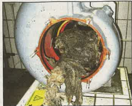
Feuchttücher verstopfen die Pumpen und werden per Hand gereinigt. Foto: AHW
