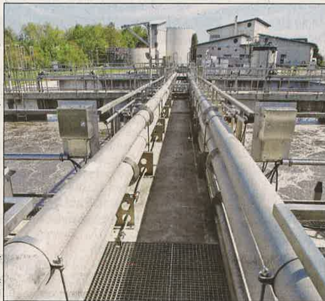
Für 300 000 Euro werden die Nachklärbecken der Anlage optimiert. So sollen die Phosphat-Werte verbessert werden.
