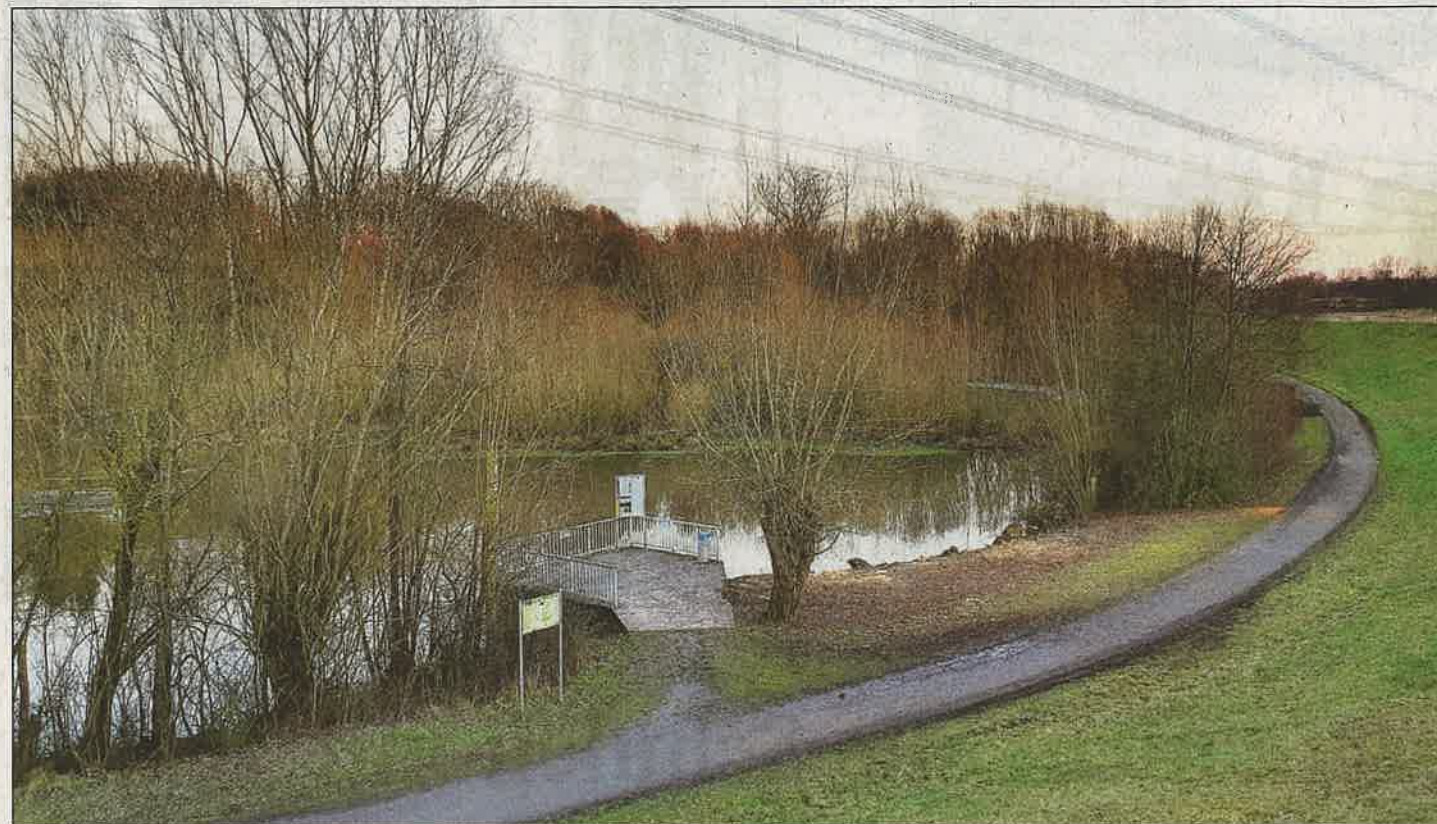
Die ersten Schritte sind gemacht: Neben der Betonplattform wurden bereits Bäume gerodet. Dort soll die Fischtreppe entstehen. Foto: Lerche
