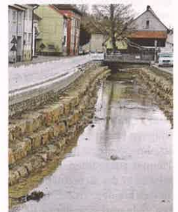
Auf einer Strecke von mehr als 100 Metern ist der Gauangelbach bereits an den Ufern befestigt Foto: sd
