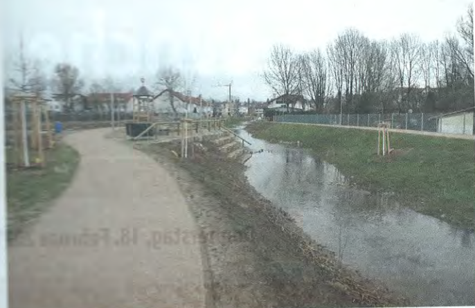
Der renaturierte und hochwassersicher gestaltete „Waldangelbach“ liegt am Rande des künftigen Neubaugebiets „Quartier am Bach“.
