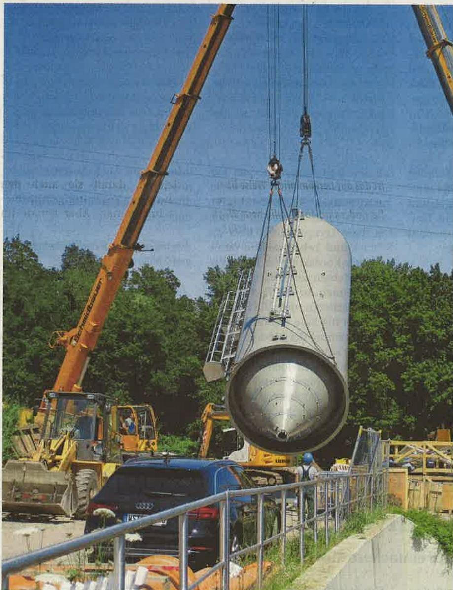
Die Aufstellung des Aktivkohle-Silos war eine sehr aufwendige Aktion. FOTOS: WEBER-INGENIEURE
