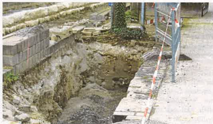
An den Seiten des Bachlaufs wird „hintermauert“
