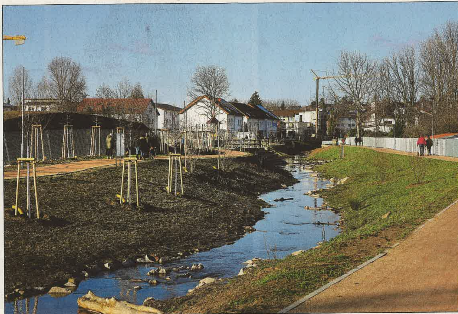
Am neu gestalteten Bachabschnitt des Waldangelbaches wurden die Bachböschungen mit heimischen Gehölzen bepflanzt. Das künftige Wohngebiet „Quartier am Bach“ wurde mit einer Baumreihe aus Zierapfelbäumen vom öffentlich nutzbaren Bereich abgegrenzt. Foto: Jan A. Pfeifer
