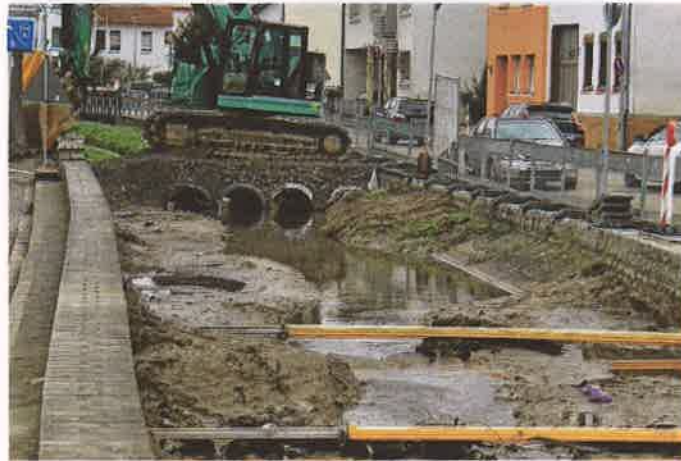
Derzeit laufen die Arbeiten am Gauangelbach in Baiertal
