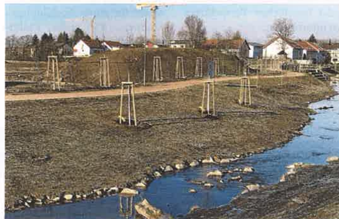
Am neu gestalteten Bachabschnitt des Waldangelbaches wurden die Bachböschungen mit heimischen Gehölzen bepflanzt. Das künftige Wohngebiet „Quartier am Bach“ wurde mit einer Baumreihe aus Zierapfelbäumen vom öffentlich nutzbaren Bereich abgegrenzt. Foto: Stadt Wiesloch
