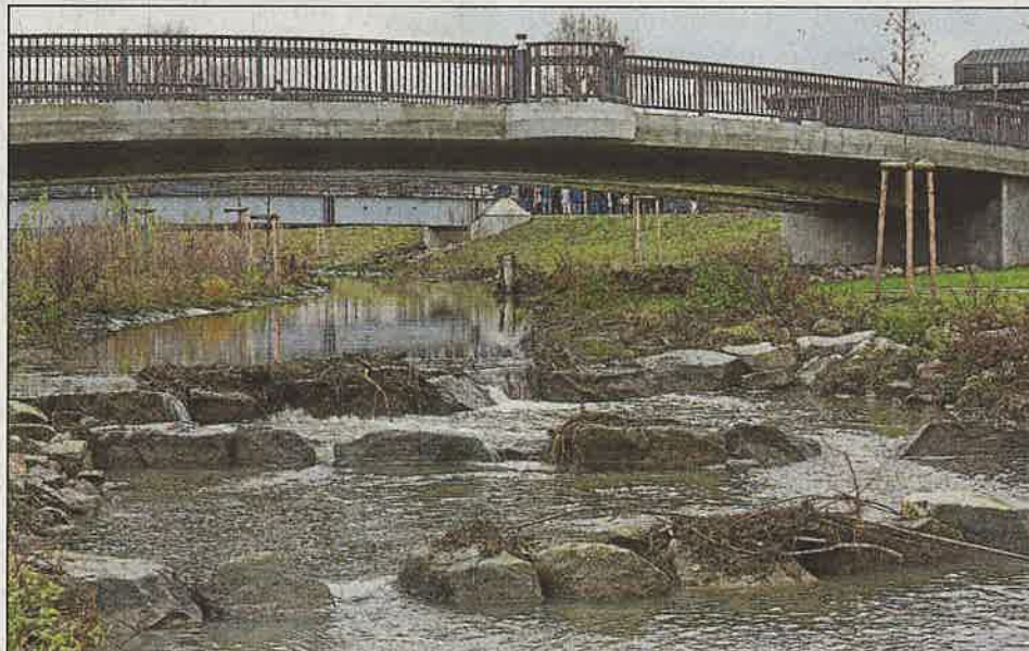
Großer Bahnhof herrschte am Freitag am neuen Gewässer in Hockenheim. Die beiden Brücken im Hintergrund waren bereits Ende 2018 eröffnet worden. Fotos: Lenhardt
