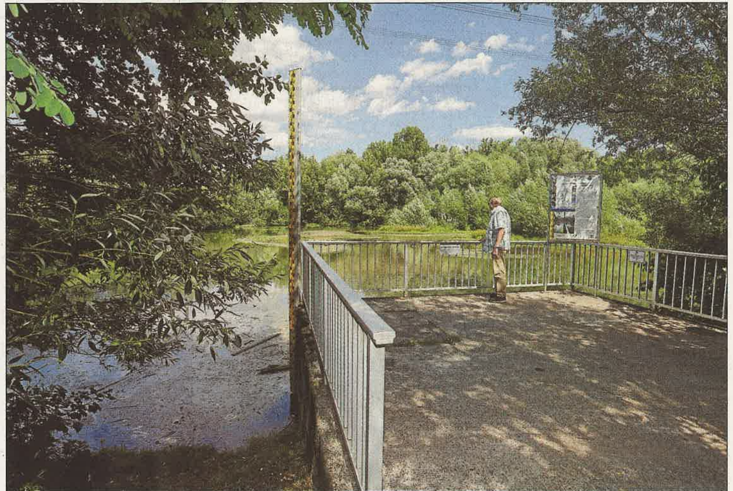
Weil die technischen Anlagen des Hochwasserrückhaltebeckens in Mühlhausen in die Jahre gekommen sind, soll es ab 2021 modernisiert werden. Insgesamt sollen 950 000 Euro investiert werden. Foto: Helmut Pfeifer
