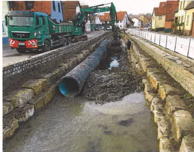
In den nächsten beiden Wochen vor der Winterpause wird der Bachlauf zwischen der Unteren Brücke und dem ersten Holzsteg in seiner künftigen Form fertiggestellt. Foto: Stadt Wiesloch
