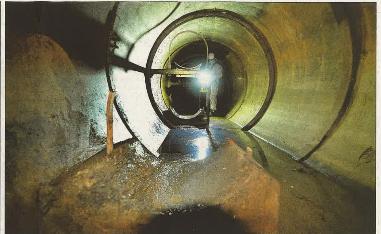
Auf dem Weg in den schlammigen Untergrund: Während der Sanierung ist eine Röhre von Mannheims größtem Düker an der Diffené-Brücke begehbar. Ansonsten fließt dort unter dem Altrhein hindurch das Abwasser ins Klärwerk bei Sandhofen. Fotos: Gerold
