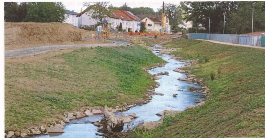
Der neue Verlauf des Waldangelbaches mit seinem geschwungenen Verlauf und den flacheren und breiteren Gewässerrandstreifen ist bereits fertiggestellt. Er wird im kommenden Herbst noch mit Gehölzen und heimischen Stauden für den Gewässerrand bepflanzt.
